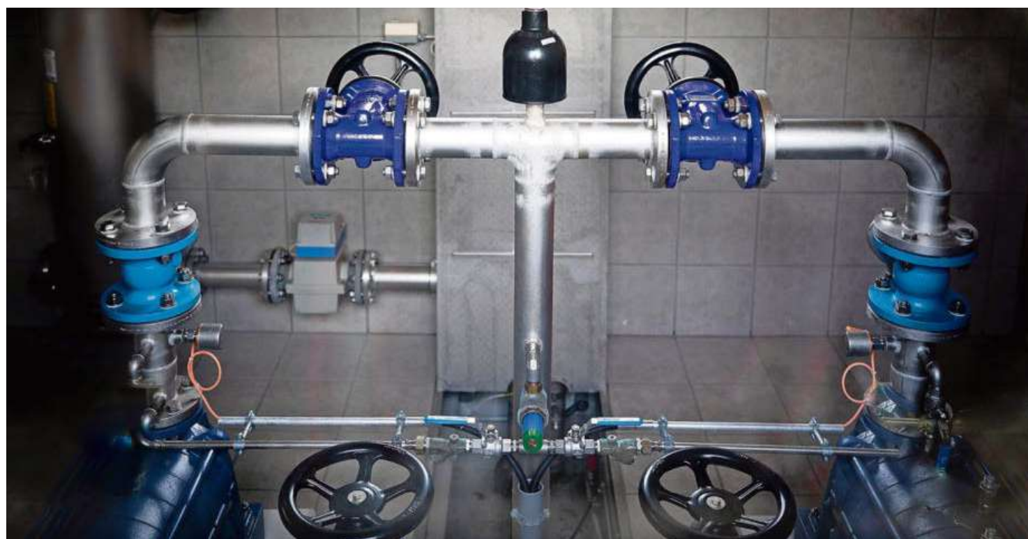
Bleibt derzeit ausser Betrieb: Das Pumpwerk in Freudwil. Archivfoto: Christian Merz
